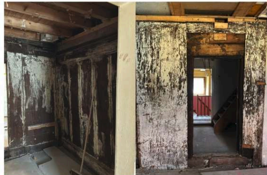
Innenaufnahmen Bestand nach Freilegung, 2026 SA
