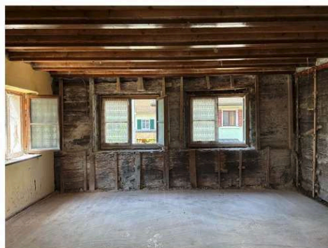
Innenaufnahme Bestand nach Freilegung, 2026 SA
