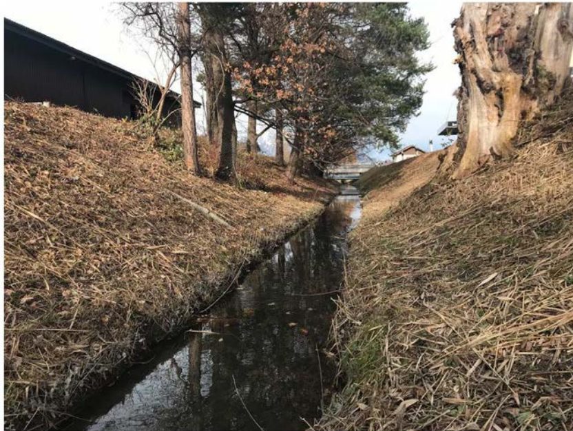
Gestaltung der Entwässerungsgräben im Industriegebiet der Gemeinde Schaan 12. Dezember 2018
