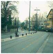
Verkehrsstreifen in der Fahrbahnmitte
