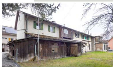
Das Gebäude vor Beginn der Arbeiten.
