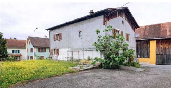
Das geschichtsträchtige Gebäude von Südosten.
