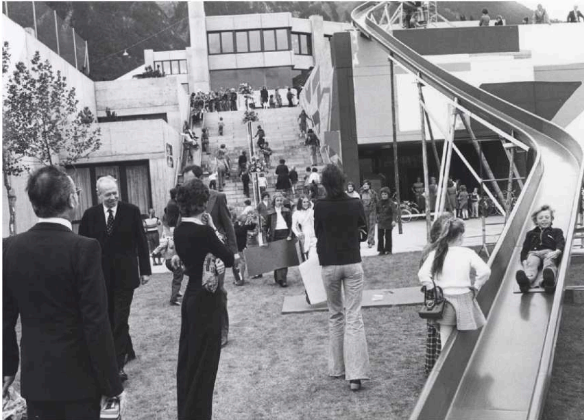
Temporäre Installationen wie eine Riesenrutsche während dem Kinderfest am 12.09.1976
