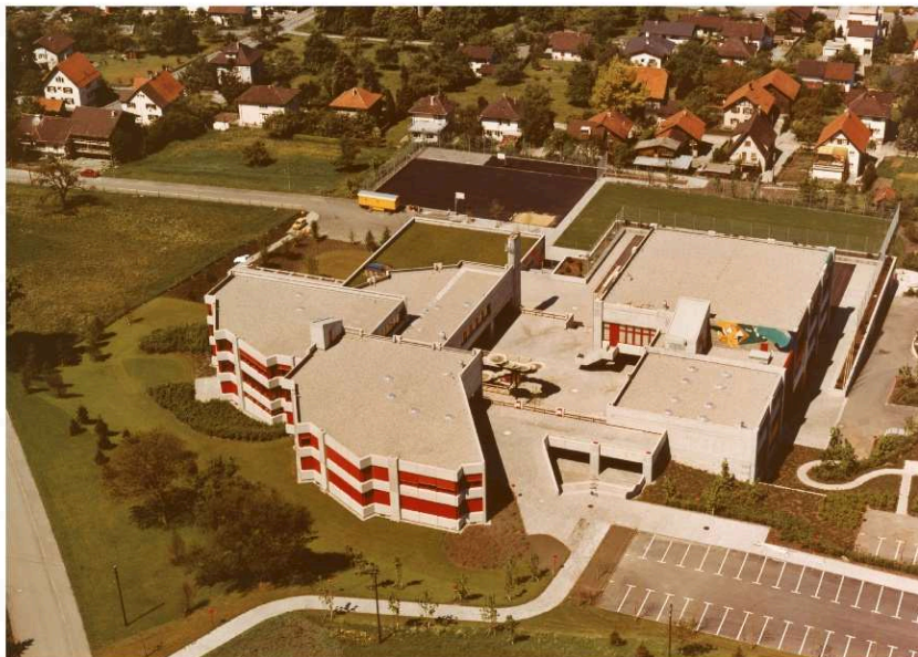
Blick auf die Schulanlage von Osten
