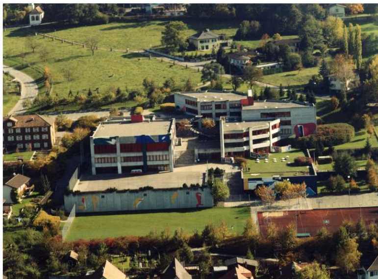
Blick auf die Schulanlage von Westen
